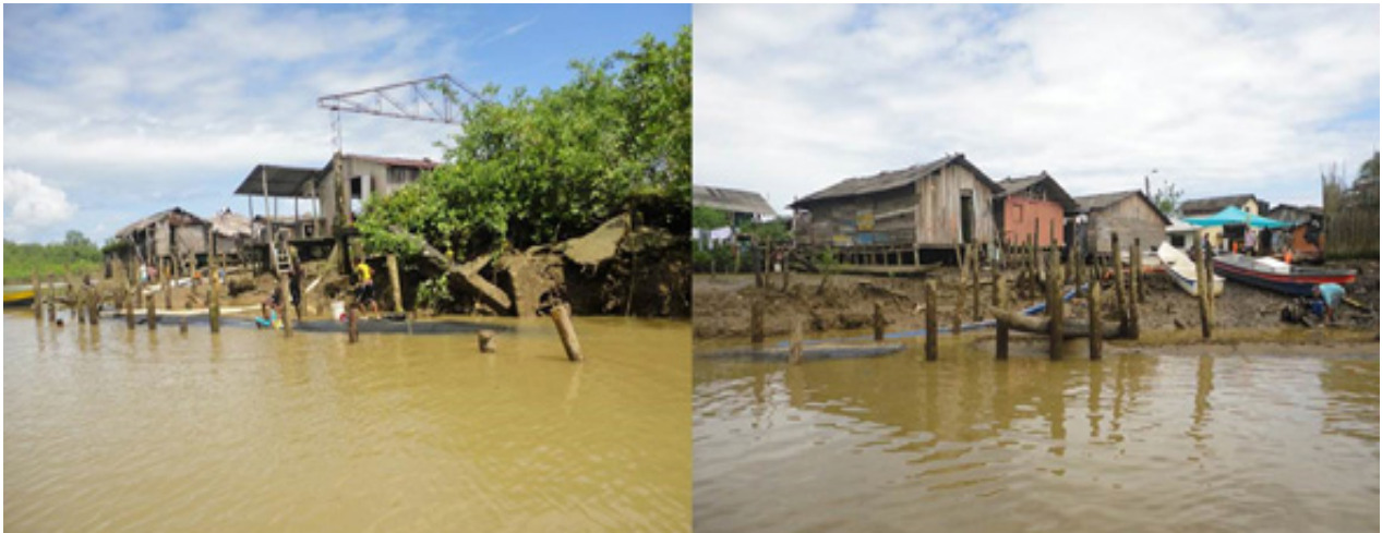
Figura 4. Erosión hídrica sobre el cauce del río Ancachí.
